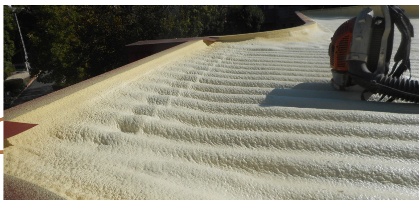
Toiture de la salle des fêtes Après isolation
