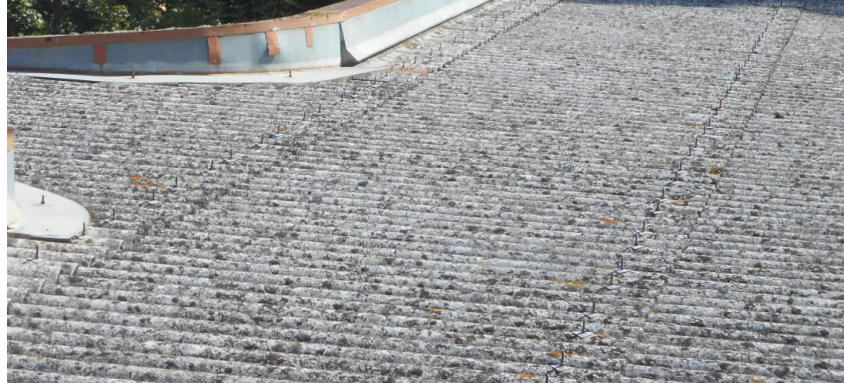
Toiture de la salle des fêtes Après isolation
